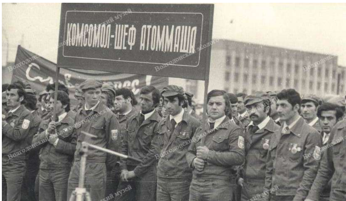
Комсомольские строительные отряды
